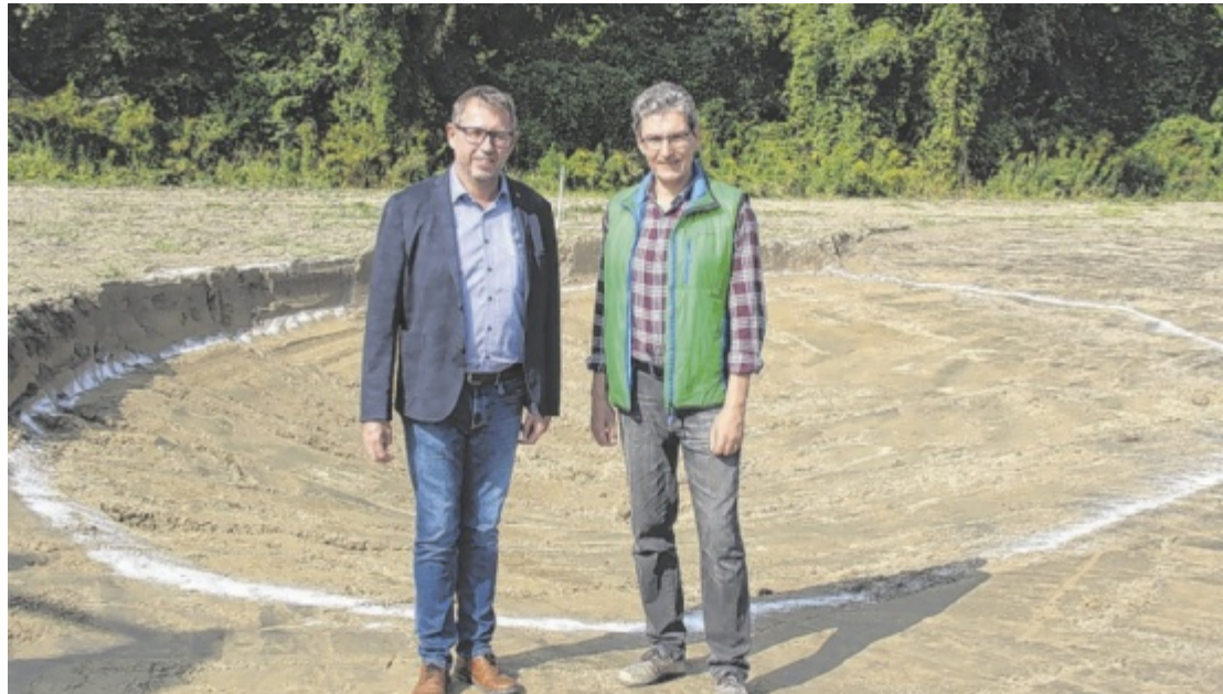
Der künftige Stadchef Christian Deleja-Hotko und Stadtrat Michael Reichhardt besuchten die Baustelle. Foto: Stadtgemeinde Enns
