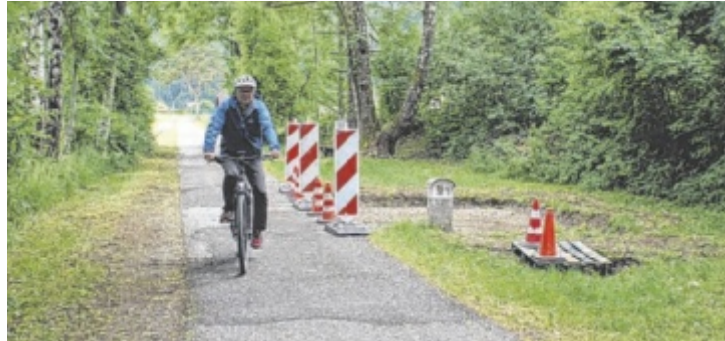
Bürgermeister Rudi Mayr bei der Baustelle für den Rastplatz in Klaus Foto: Kepplinger
